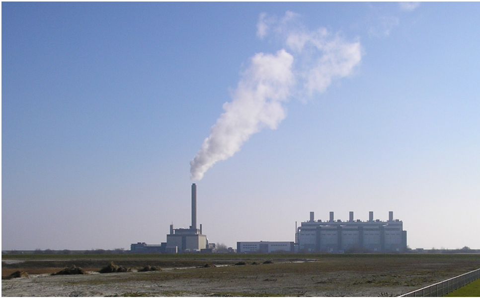
Figuur 6.11: De Eemscentrale van Electrabel in de Eemshaven, Groningen (I.Nikolic, 2006)
