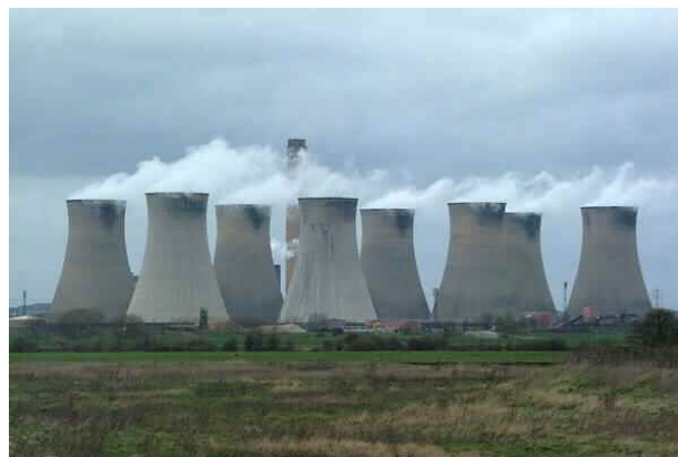
Figuur 3.4: Elektriciteitscentrale met veel koeltorens (bron: http://www.freefoto.com by Ian Britton)
